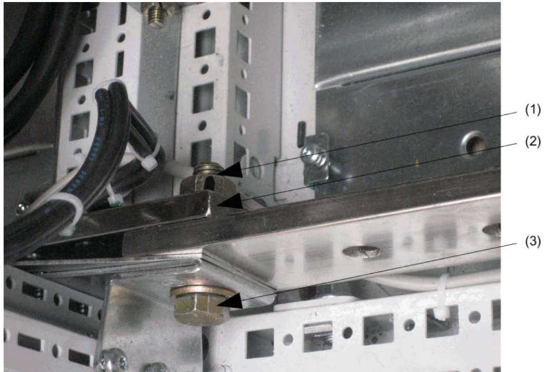
Esquema 4-3 Ligação das barras PE
