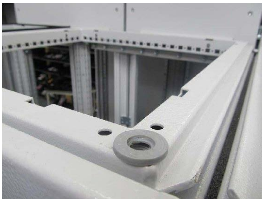
Esquema 3-18 Colocação das anilhas planas
