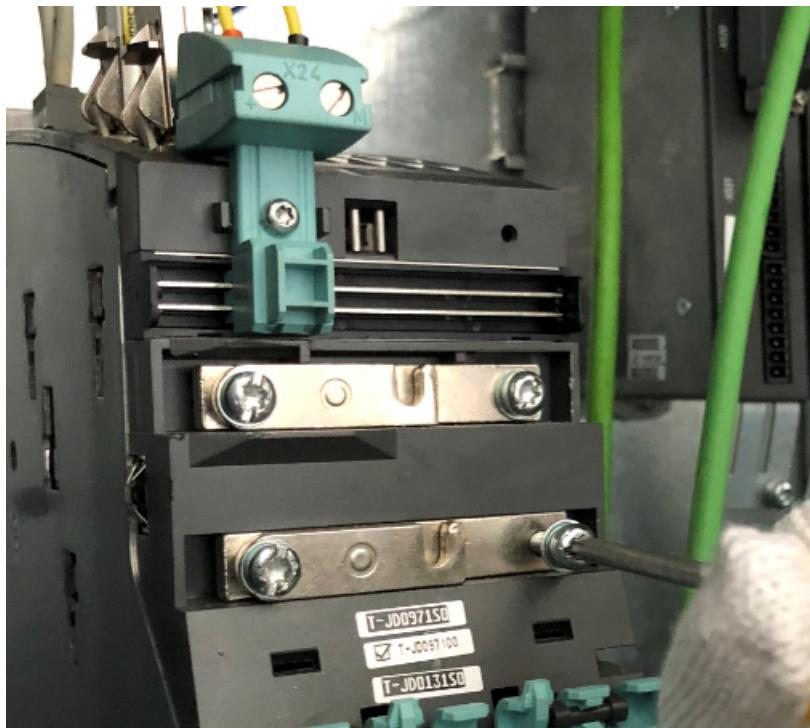
7. 将直流母线电缆的环形接线端子连接至待连接组件直流母线母排的螺钉上。
