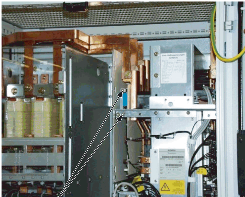
Bild 4-4 Entfernen des Verbindungsbügels zum Entstörkondensator
