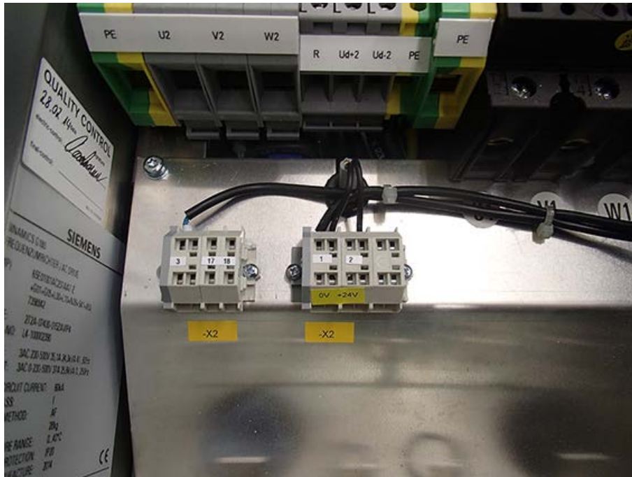
Bild 6-5 Anschluss für externe Steuerspannung
